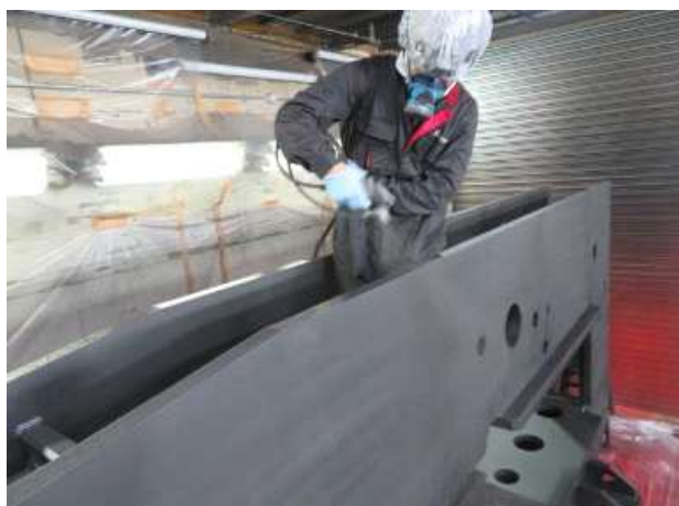
フレーム塗装工程で上塗りを廃止。化学物質物質削減効果のほか、高所作業も削減され作業効率化につながる
