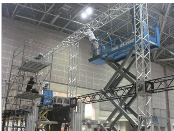
MF-Tokyo展にて躯体部設置。部材はリユースされている。
