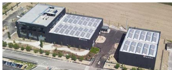
AMADA ITALIA S. r. l. 太陽光パネル。
