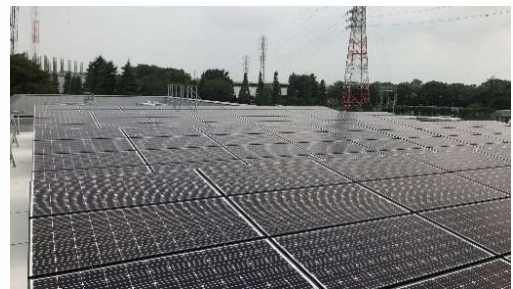
屋顶安装的太阳能电板
