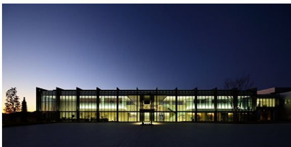
テクニカルセンター照明
