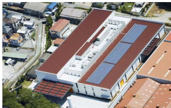
太陽光パネル
