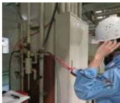
エア漏れパトロール(富士宮事業所)
