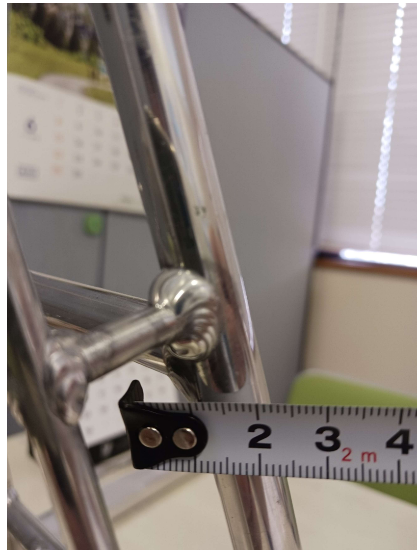
継ぎ手部の溶接ビード
