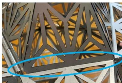
図8 修正後のサービスホール（隙間小）
