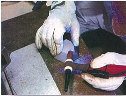
仮止め（TIG 溶接）
